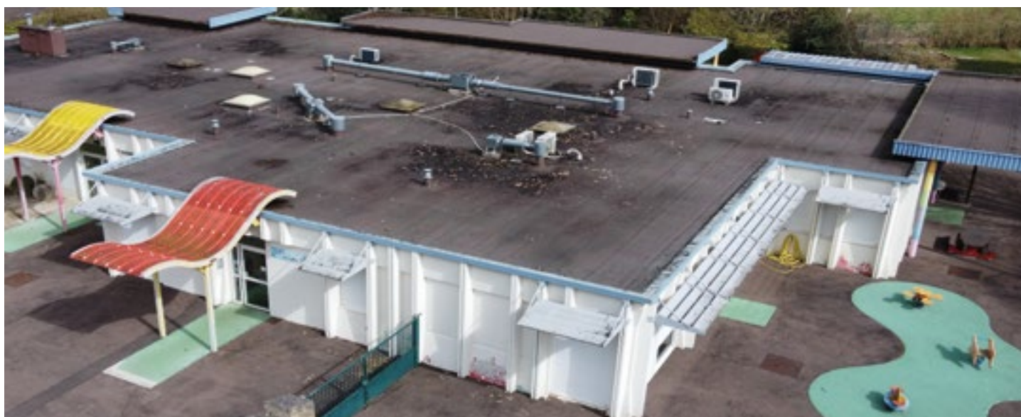
► Des travaux à la Maison de la petite enfance sont prévus au budget 2025.
