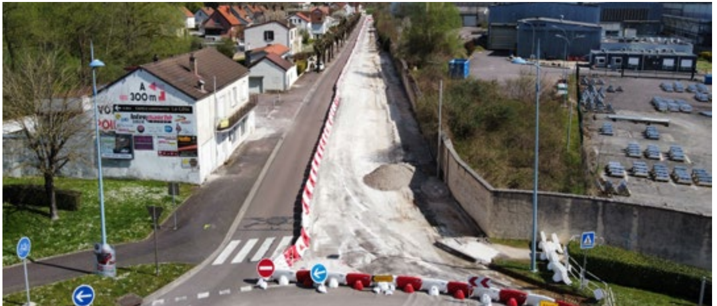
► Les travaux ont débuté par l'avenue du Maréchal Leclerc.
